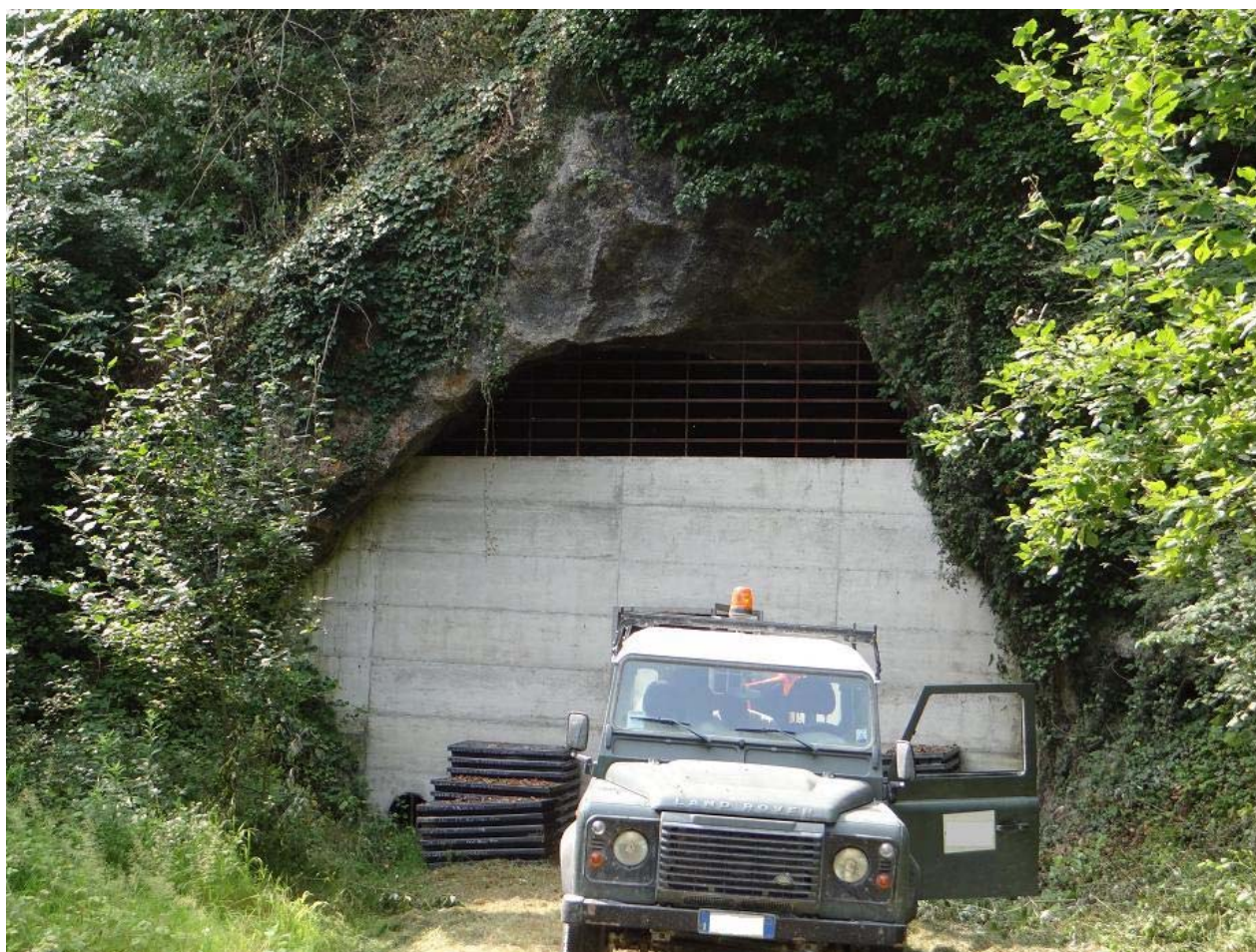
Figura 30: dettaglio fotografico ingresso cava
