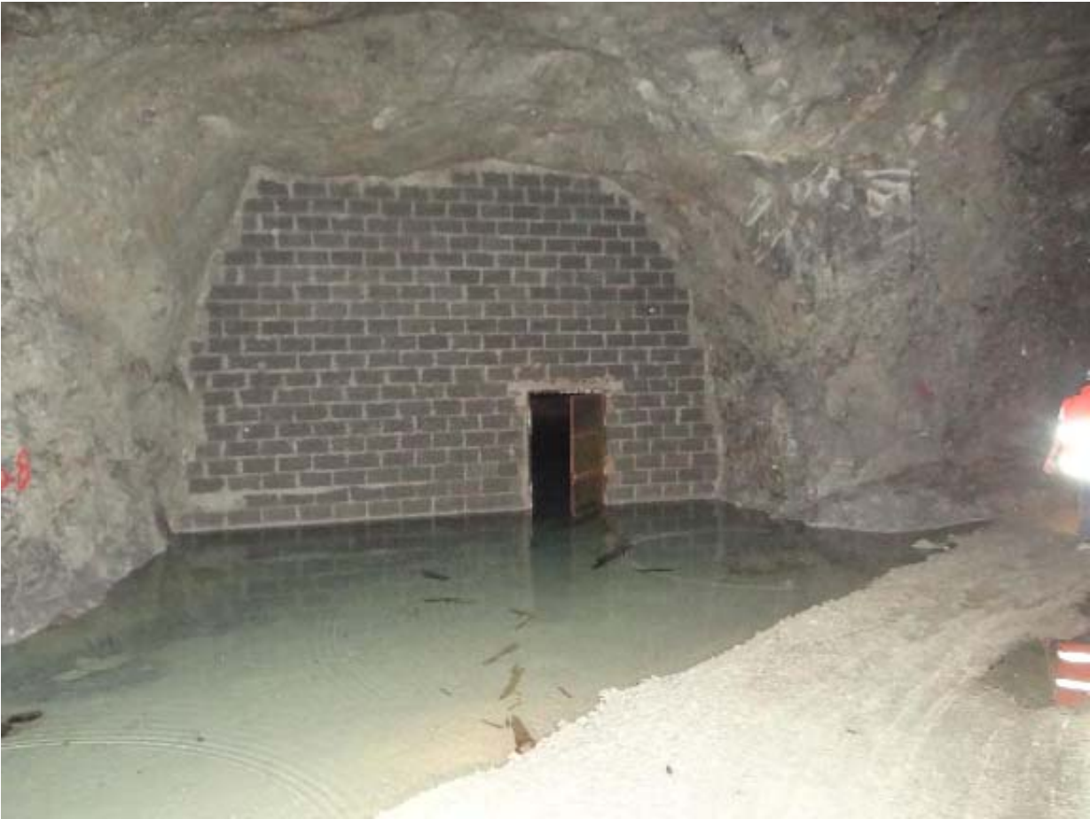
Figura 31: limitata zona di accumulo di acque all'interno di una cava
