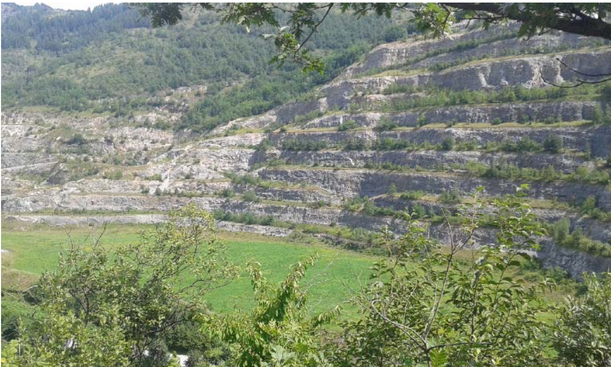
Figura 22: vista frontale di piazzale e fronte di cava
